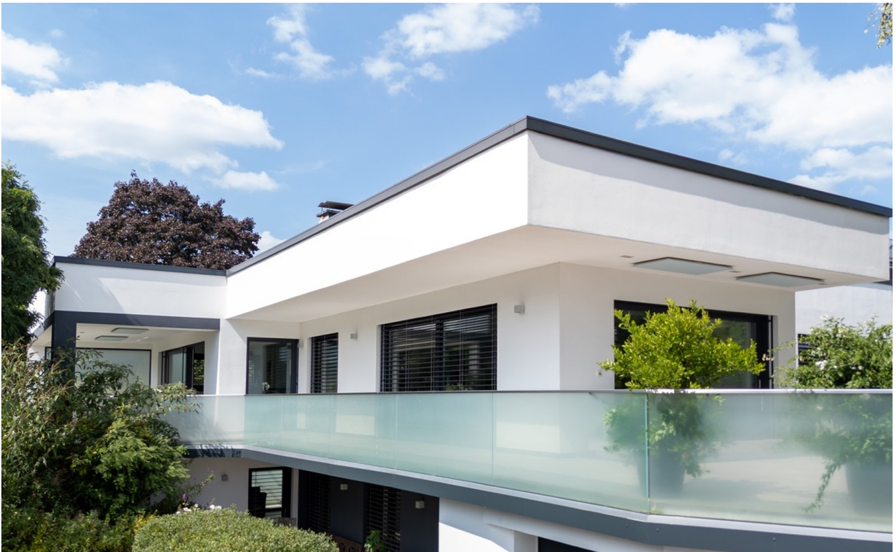
Blick auf Verbindungsbalkon
