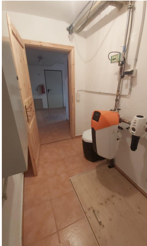
Entkalkungsanlage
