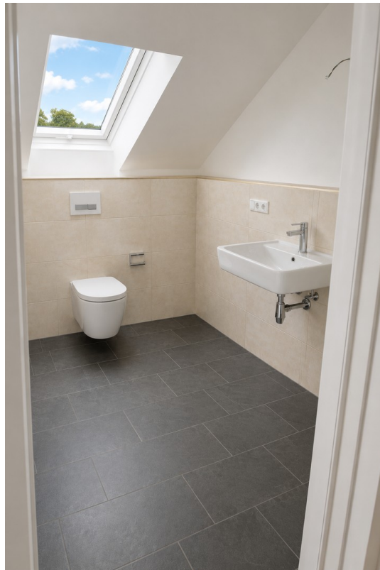
DG Bad mit Dusche
