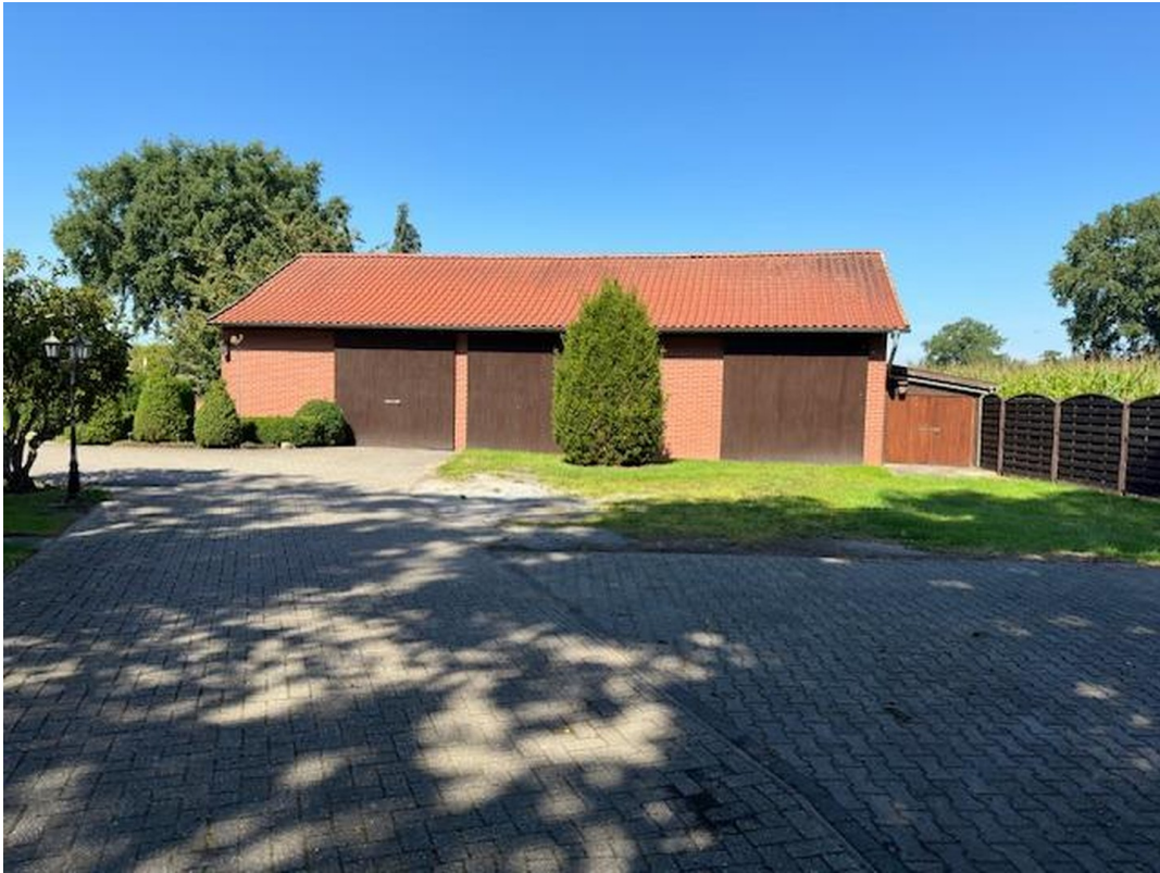
Ansicht Scheune hinten
