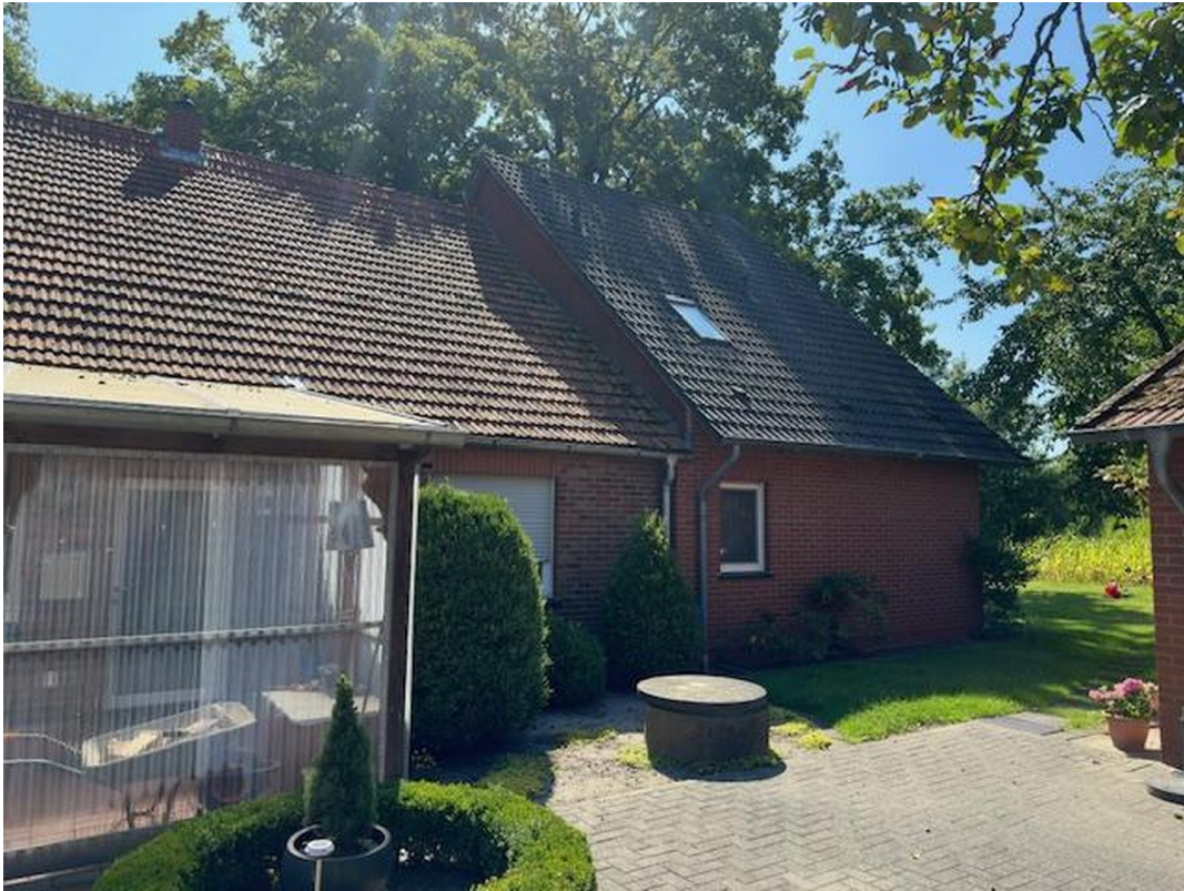
Ansicht Altbau Richtung Anbau
