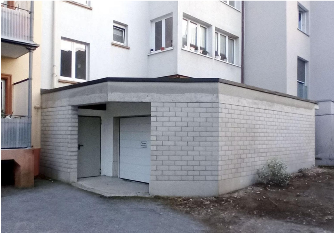
Lager von außen
