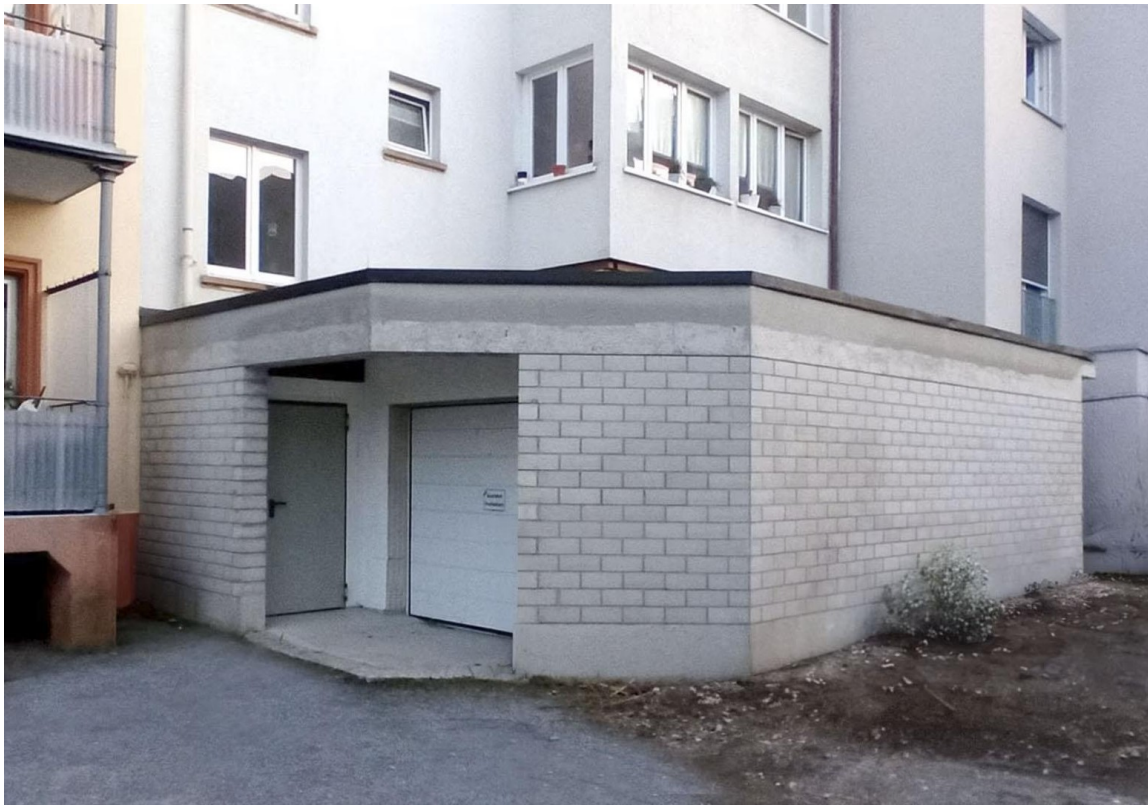
Lager von außen
