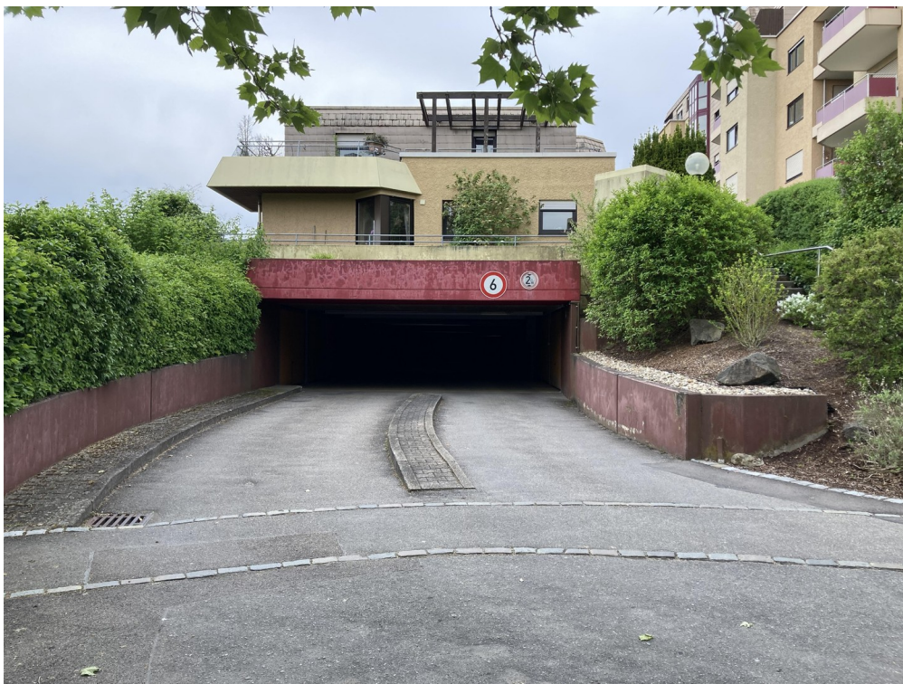
Einfahrt in die Tiefgarage
