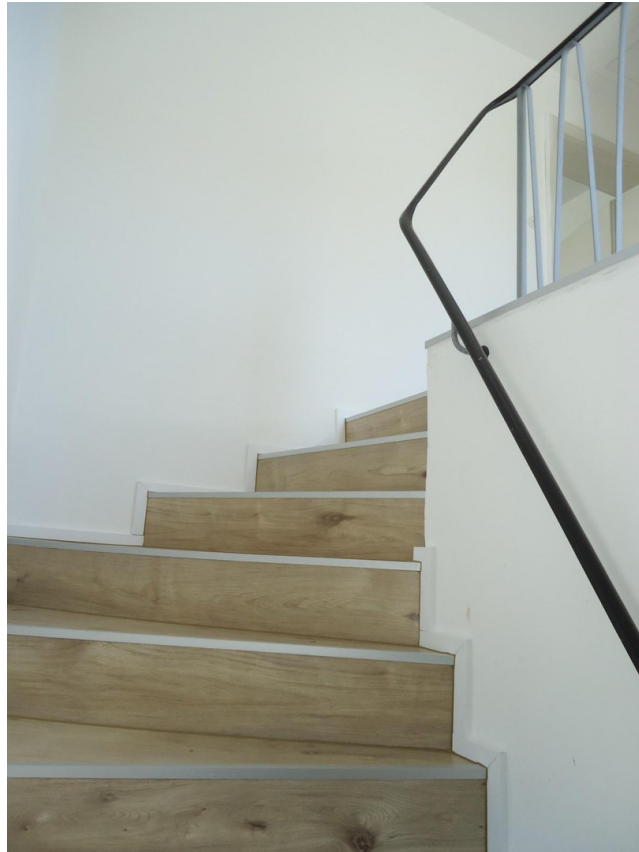
Treppe Ansicht vom EG zum 1.OG
