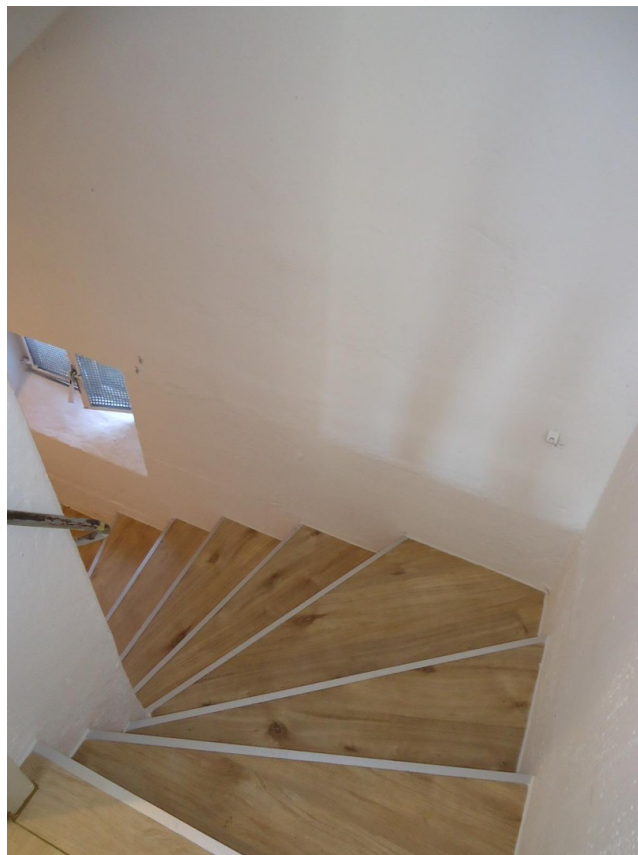
Treppe Ansicht vom EG zum UG
