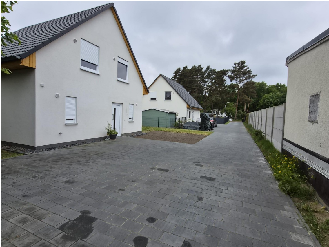
Hausansicht und Auffahrt
