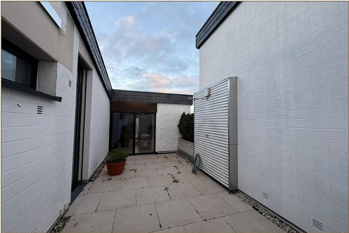
Dachterasse OG - Hautohaus
