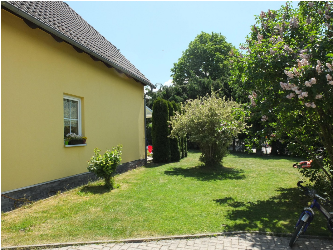
Seitenansicht von Garage aus
