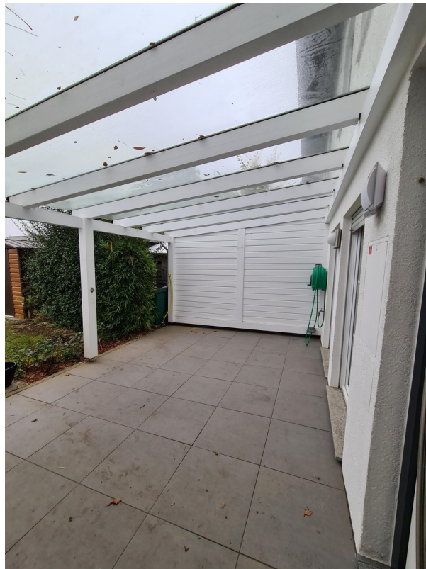
Überdachte Terrasse Eingang
