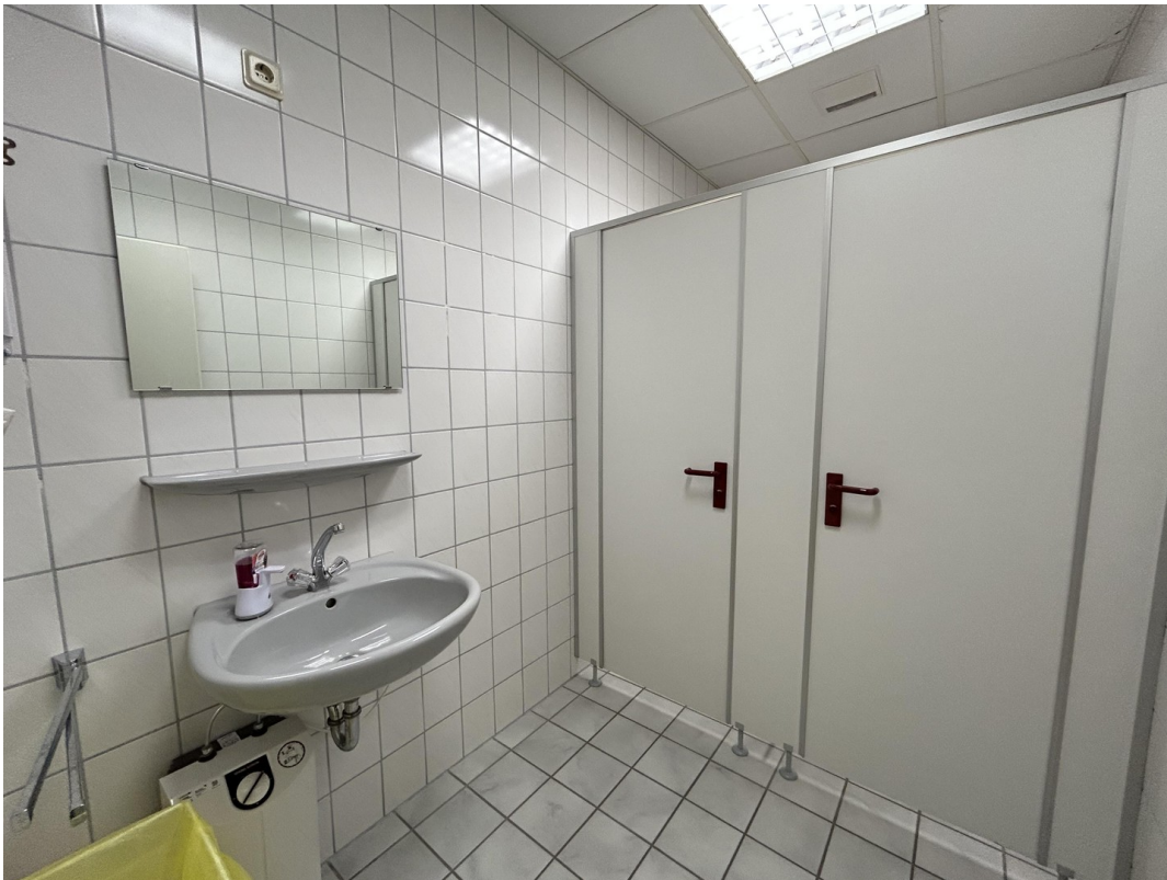
Sanitärbereich pro Stockwerk
