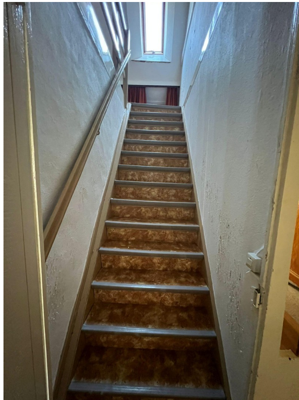
Treppe ins DG
