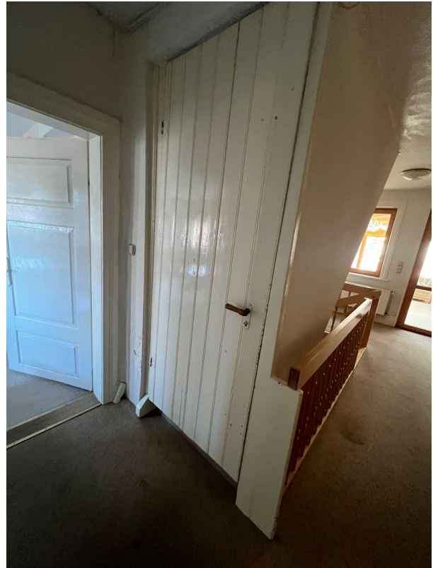
Flur Treppe ins DG
