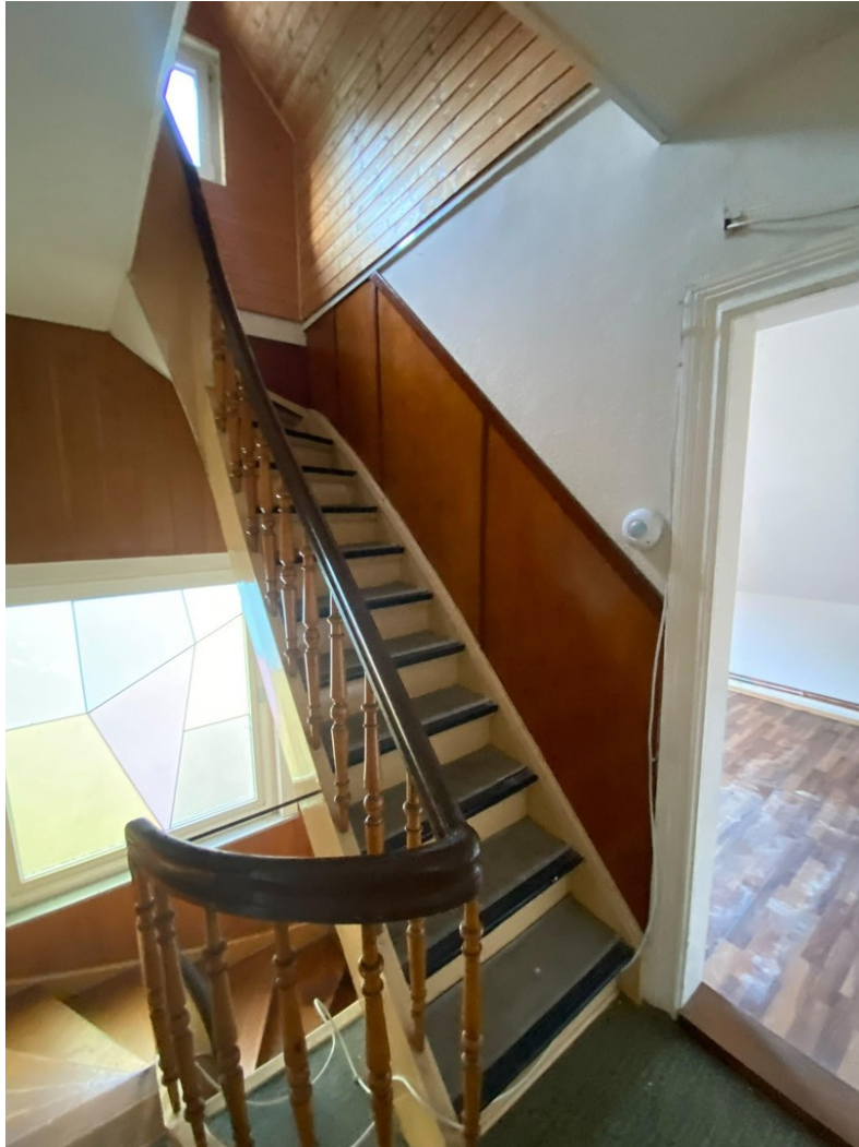
Treppe zum Dachboden
