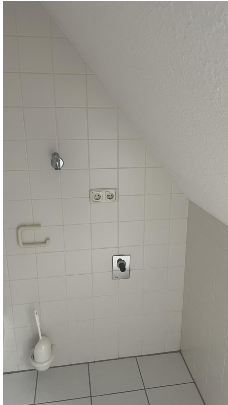
Waschmaschinenanschluss
