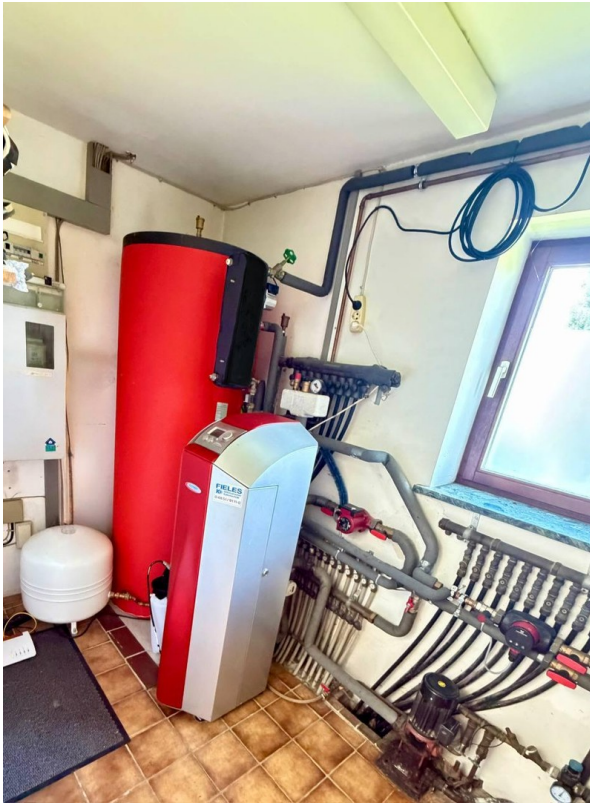
Heizungsanlage Wärmepumpe
