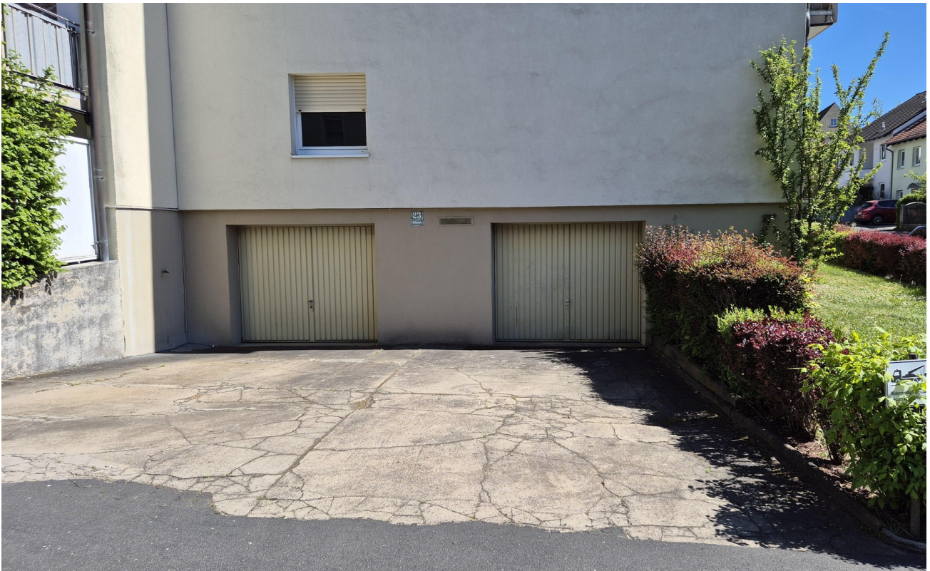
Garage rechts Außenansicht
