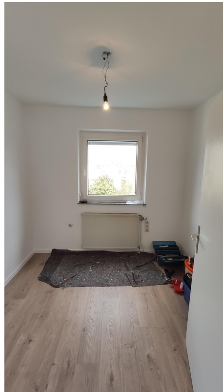
Arbeitszimmer im EG
