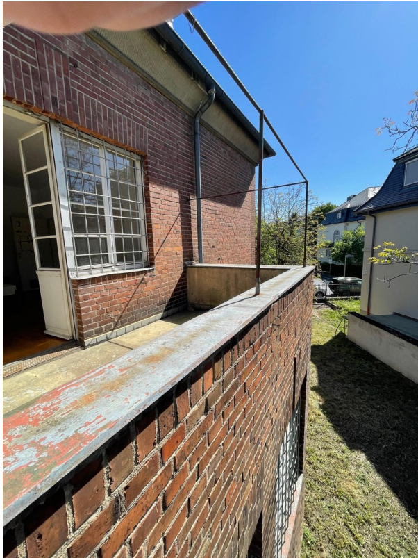
OG Balkon West
