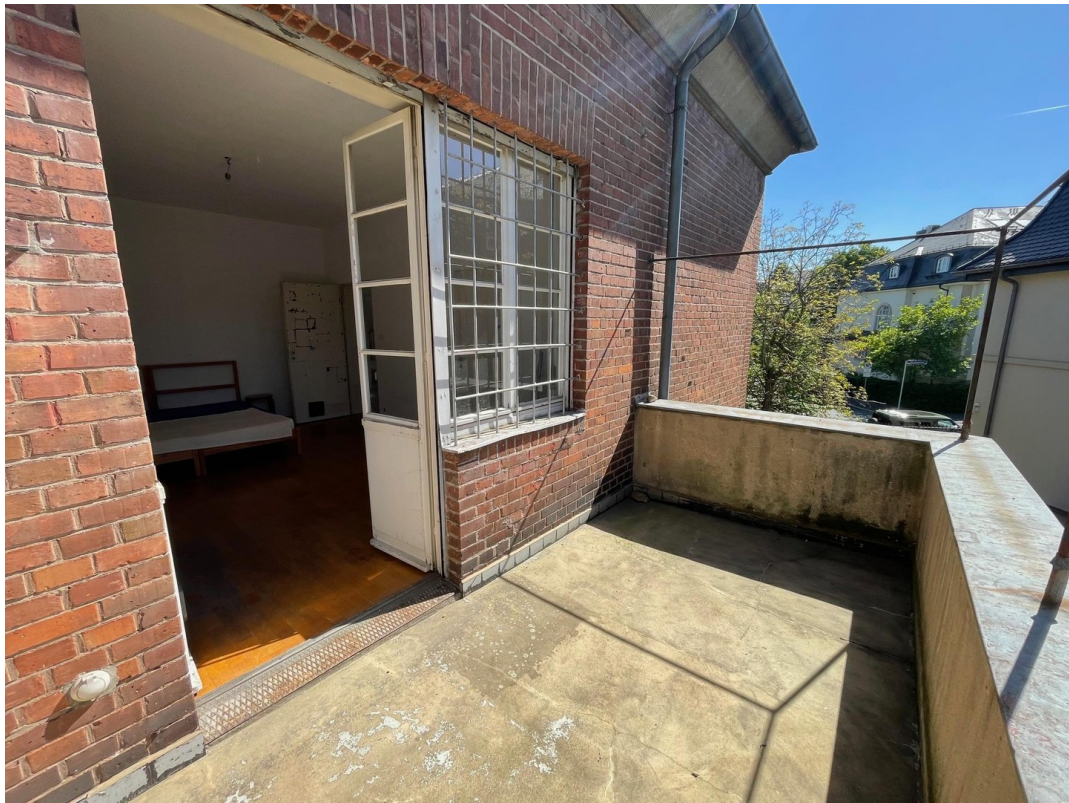
OG Balkon West
