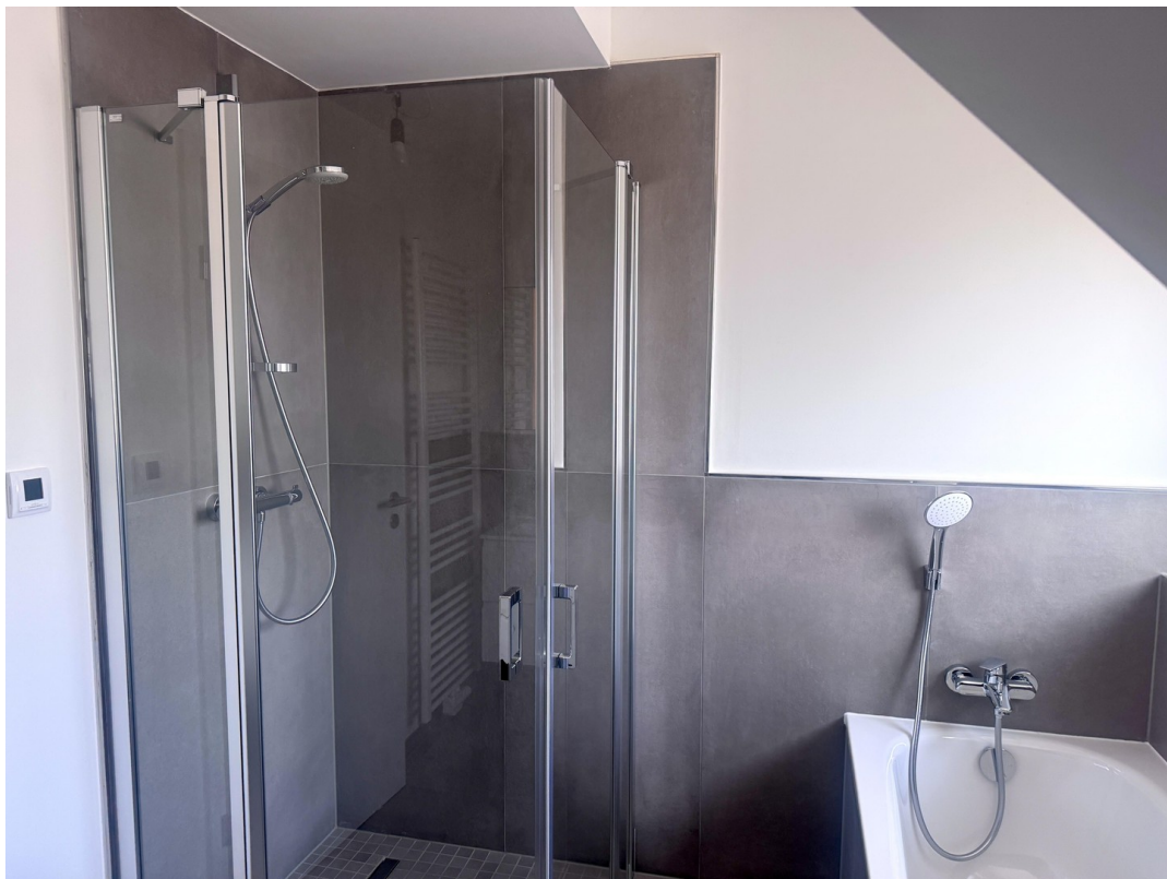
oberes Bad Dusche
