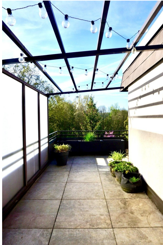
Zugang zur Terrasse/Treppehaus
