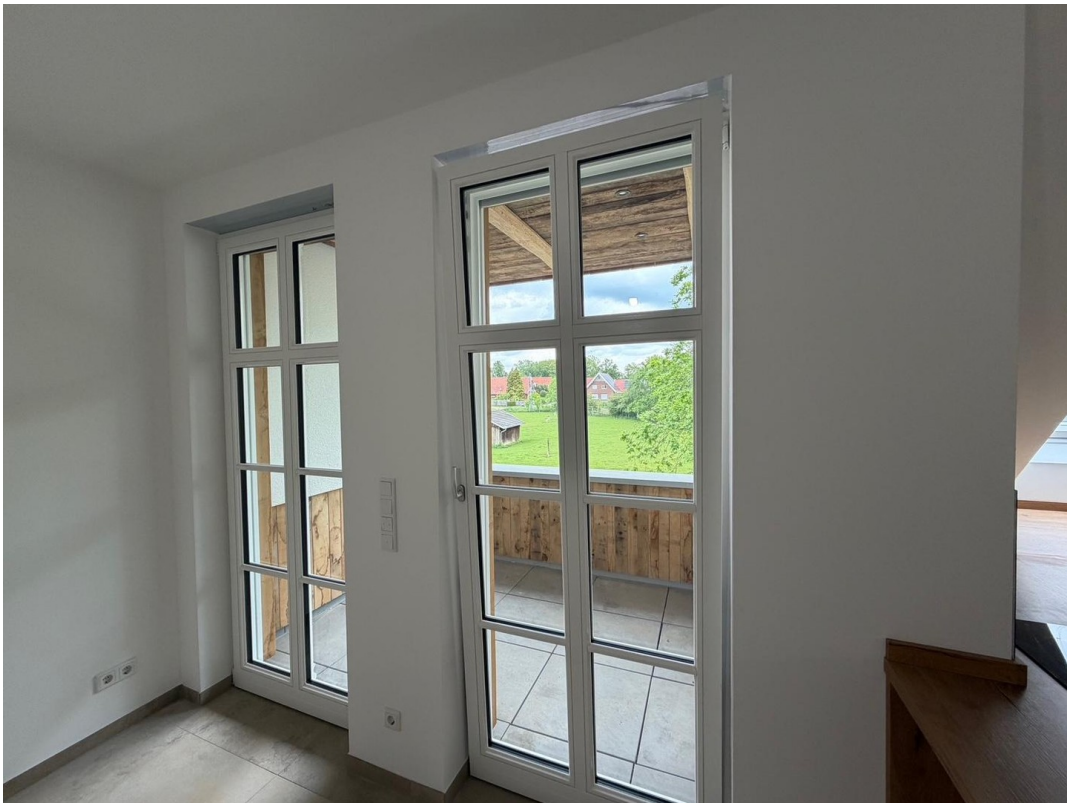
Ausgang zur Loggia
