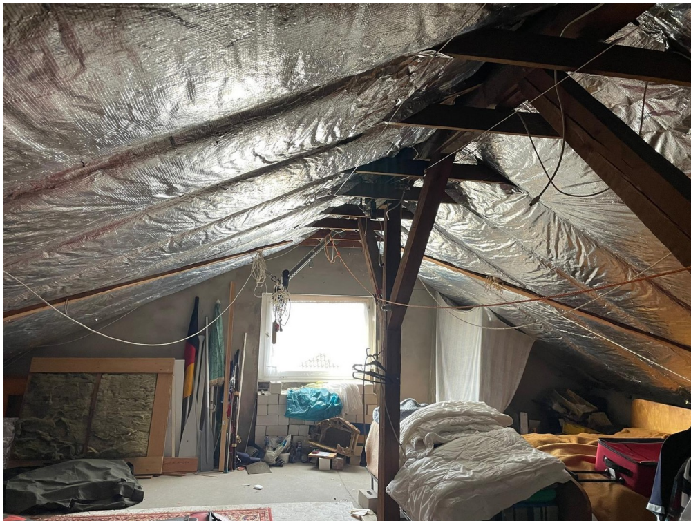
Gedämmtes Dachgeschoss
