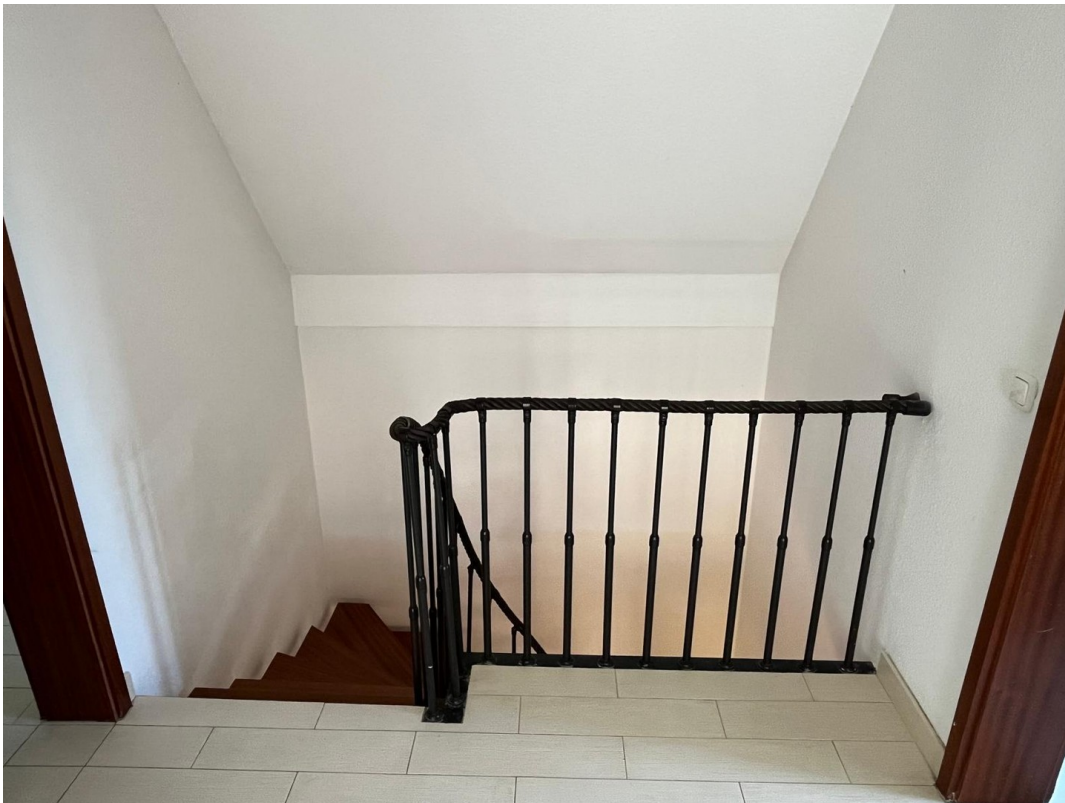
Empore/Flur OG - Blick hinab
