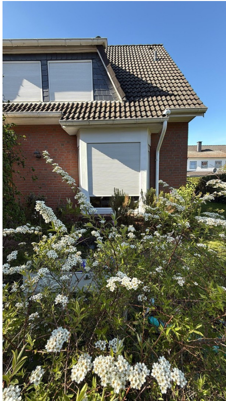
Erkerfenster Küche (Südseite)
