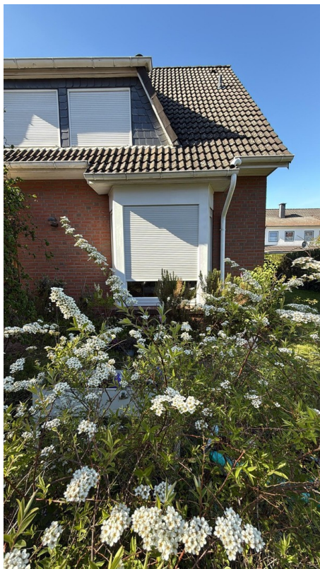
Erkerfenster Küche (Südseite)
