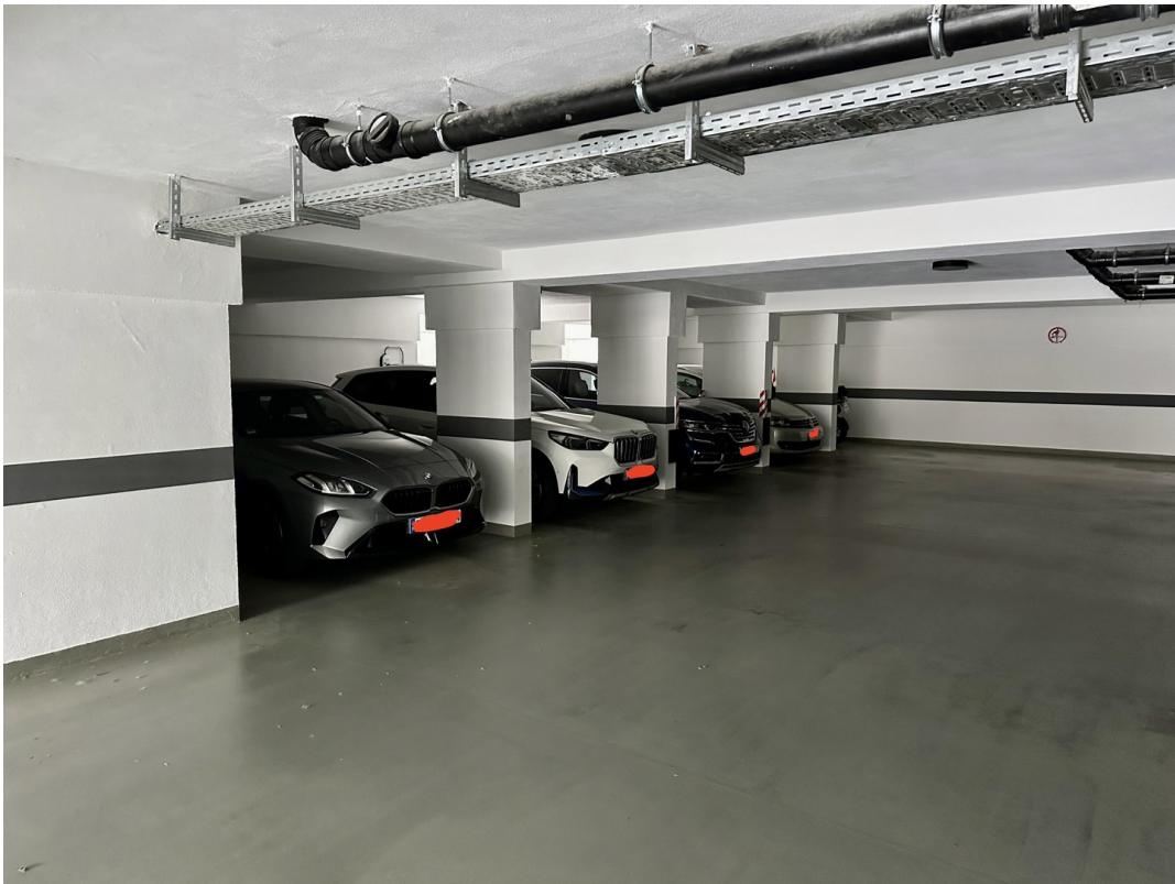
Stellplätze in der Tiefgarage
