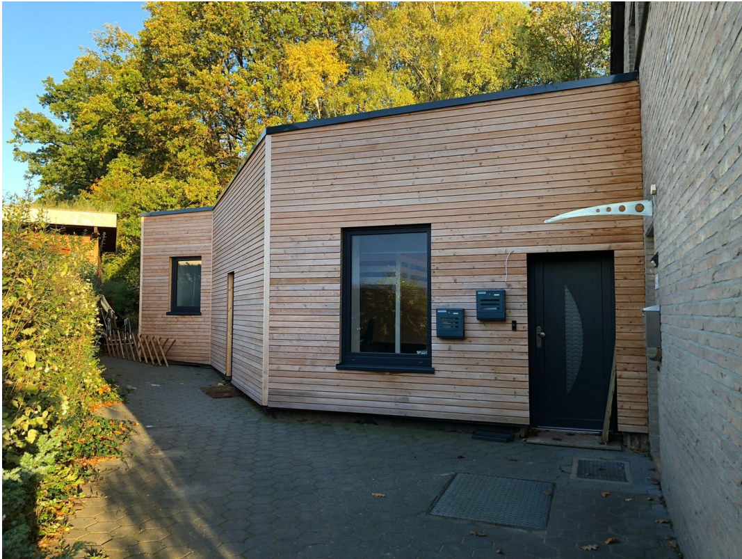
Blick auf den Flachdachteil
