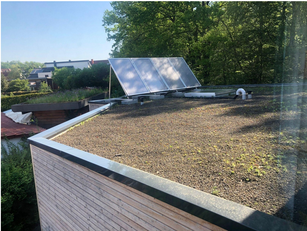
Blick auf das grüne Flachdach
