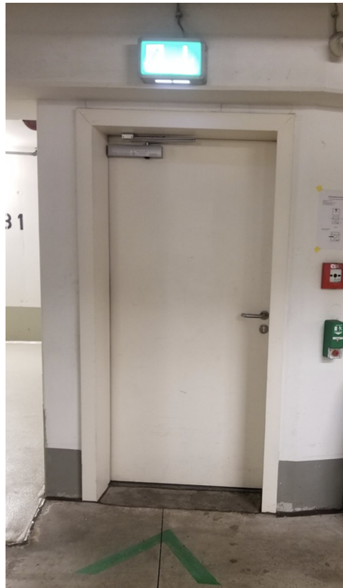
Zugang ins Treppenhaus
