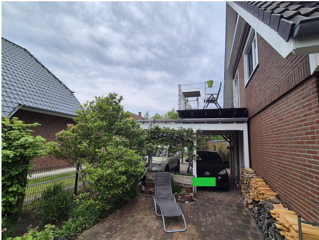
Doppelcarport mit Dachterrasse
