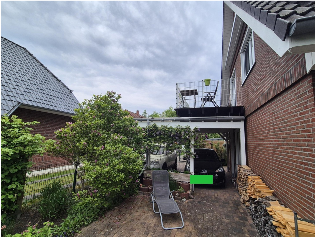
Doppelcarport mit Dachterrasse
