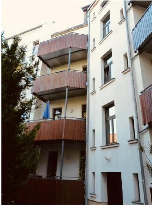
Fassade zum Innenhof
