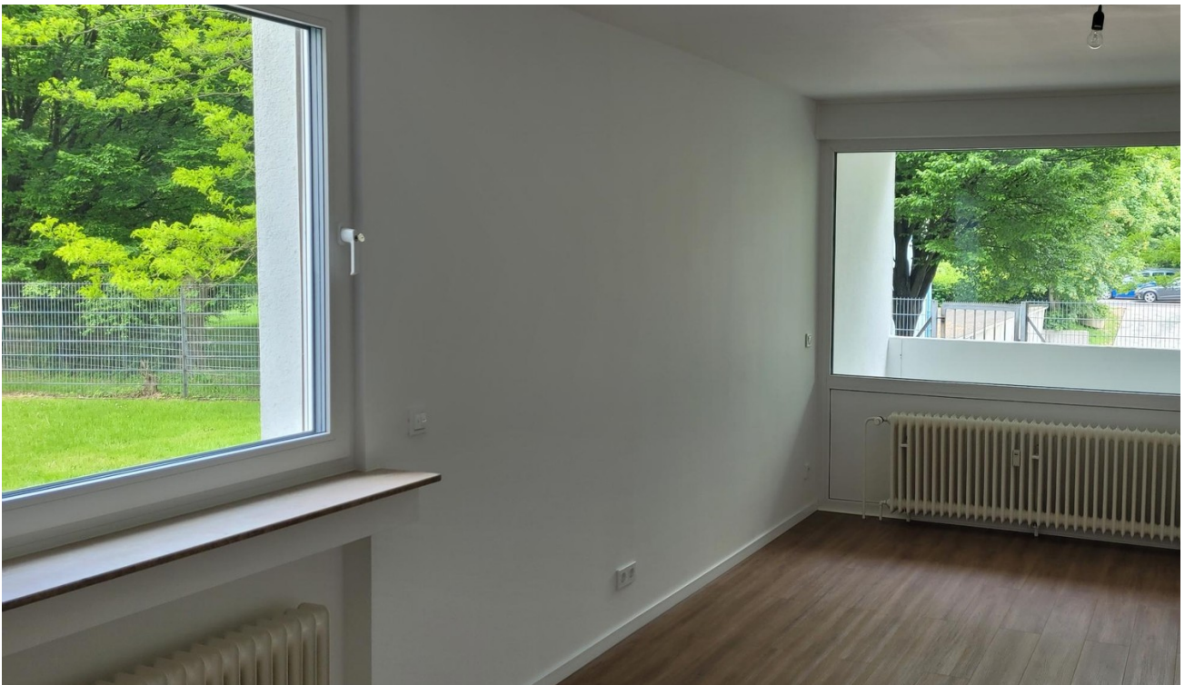
Fensterflächen im Wohnzimmer
