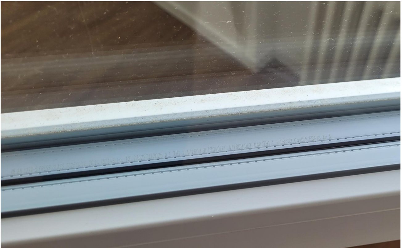
3-fach verglastes Fensterdetail
