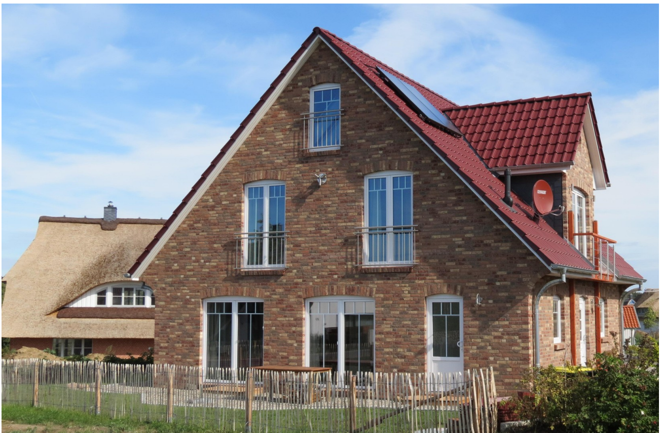
Nebeneingangstür mit Terrasse
