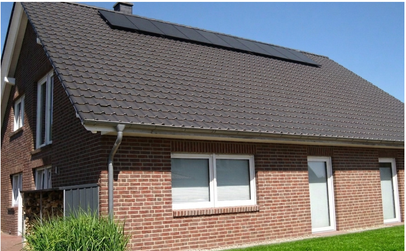
Seitenansicht zur Straße
