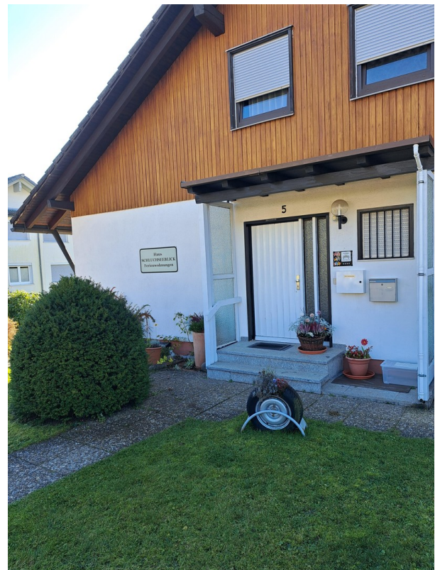
Haus Eingangsseite links
