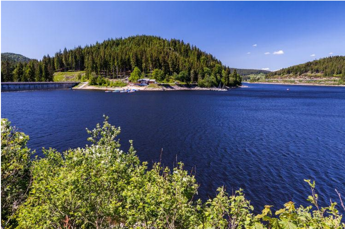
Schluchsee und Staumauer
