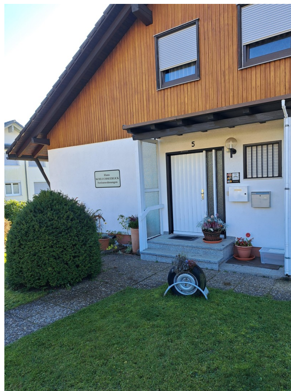
Haus Eingangsseite links
