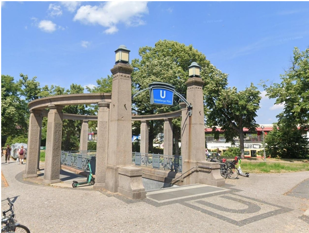
U3-Bahn Heidelberg Platz
