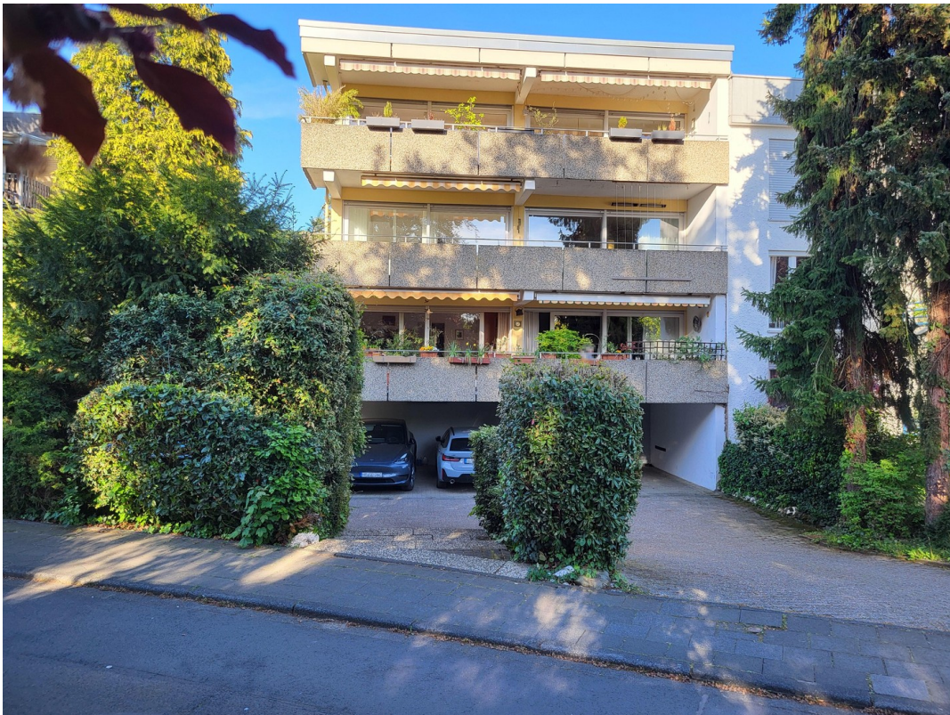
Straßenansicht des Hauses
