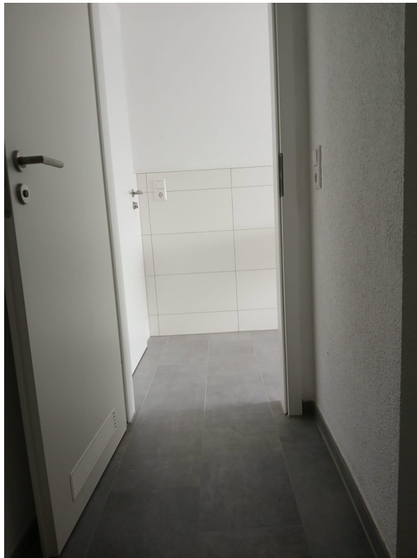
Blich aus HW-Raum ins Bad
