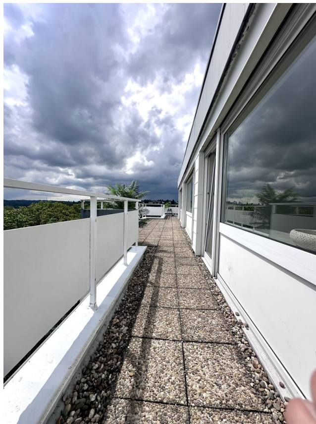
Dachterrasse vor W/S-Zimmern
