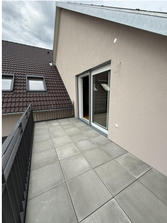
Balkon mit Westausrichtung
