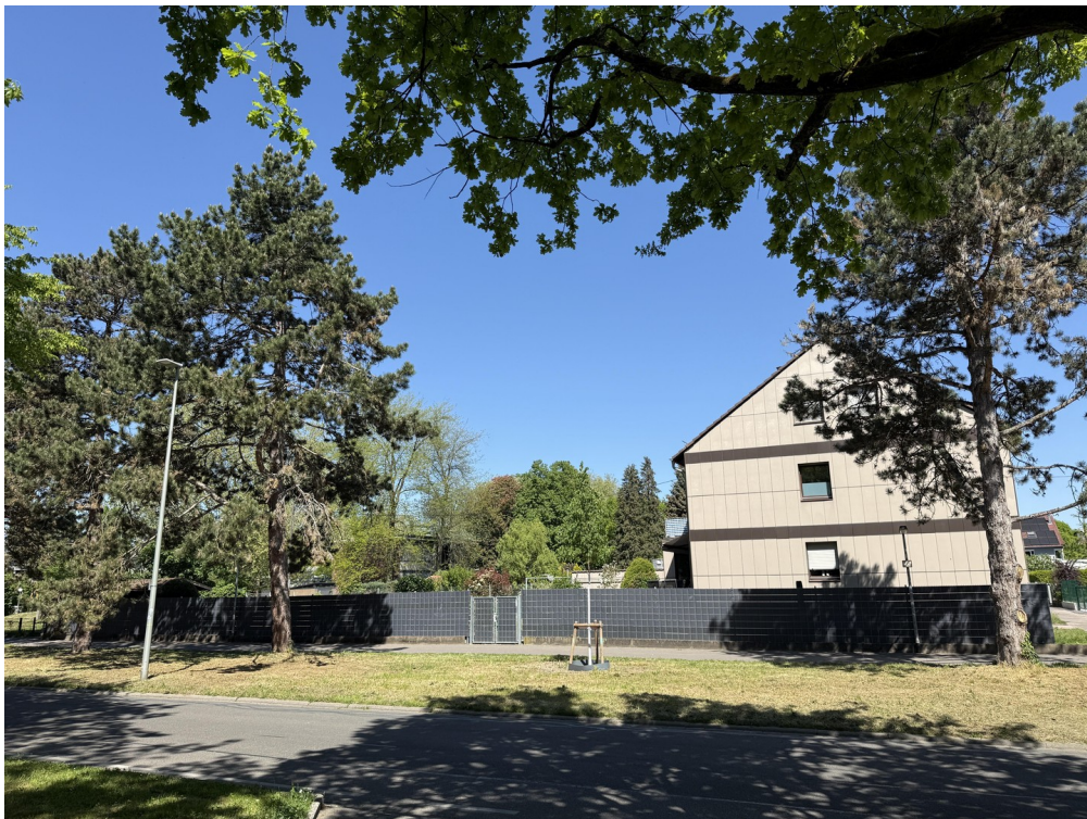
Gesamtansicht von der Straße
