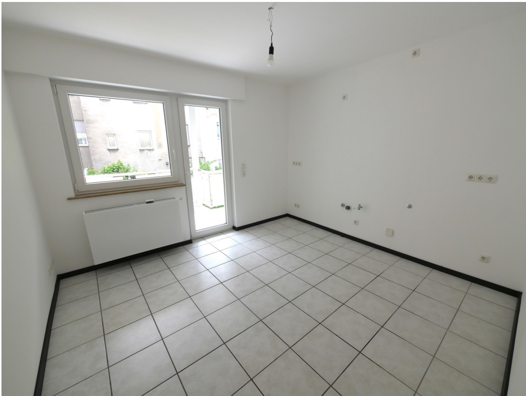
Küche mit Anschlüssen
