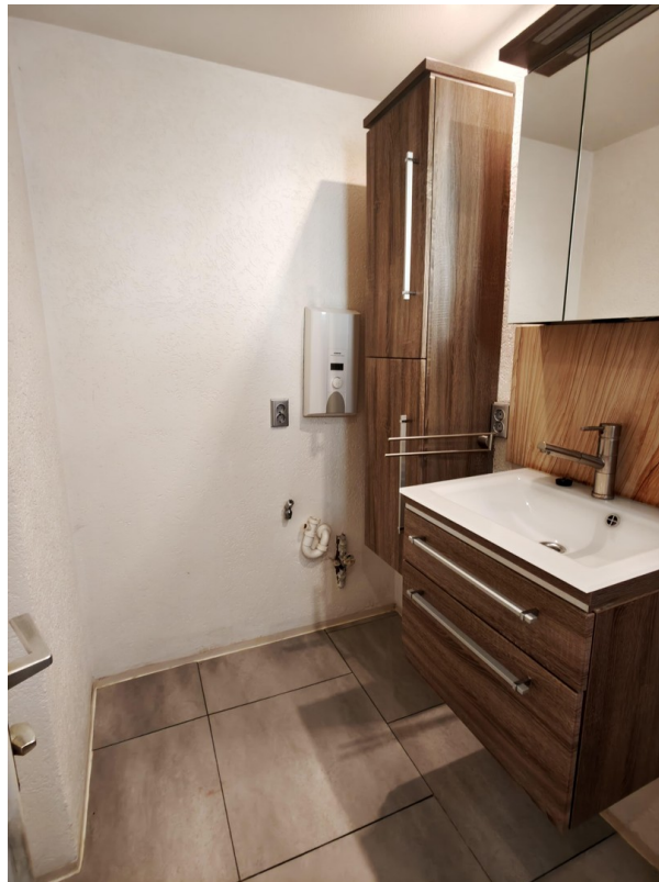
Bad EG Waschmaschinen anschluss
