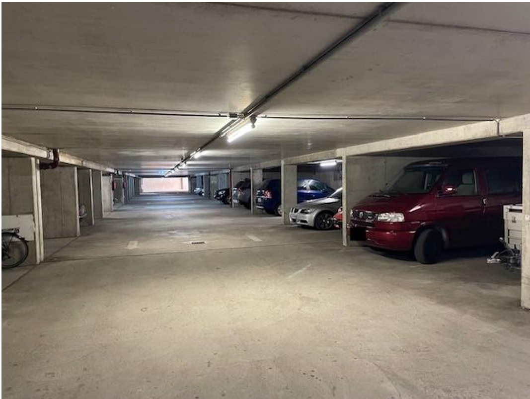
Blick zur Einfahrt
