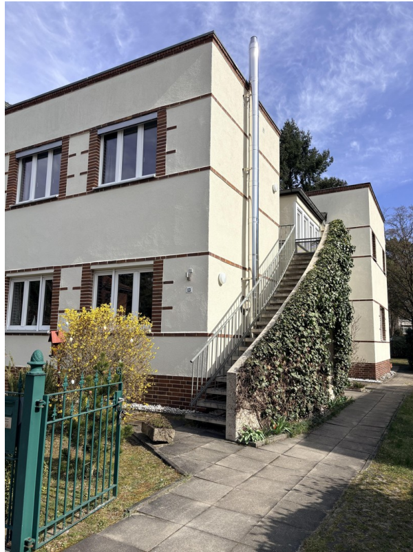
Seitenansicht mit Außentreppe
