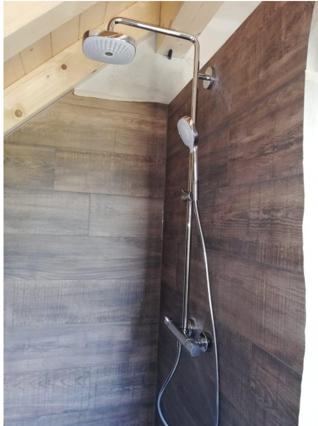
Dusche OG Neubau
