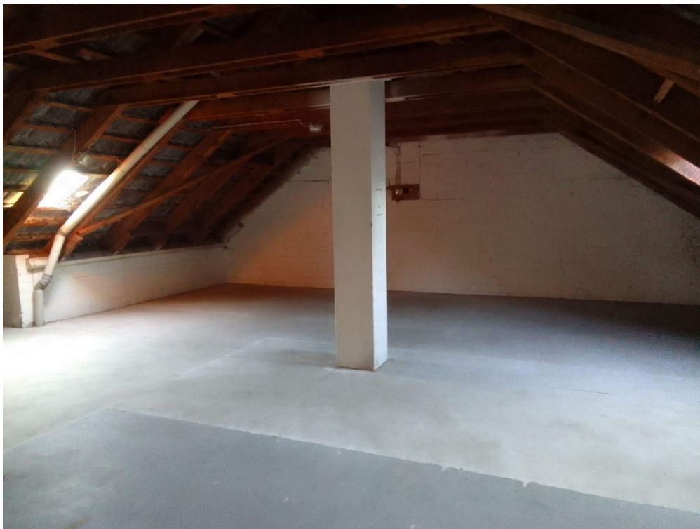
zum Ausbau vorb. Dachboden
