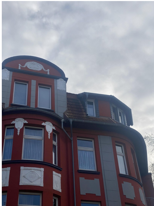
Dach und Denkmalschutzfassade
