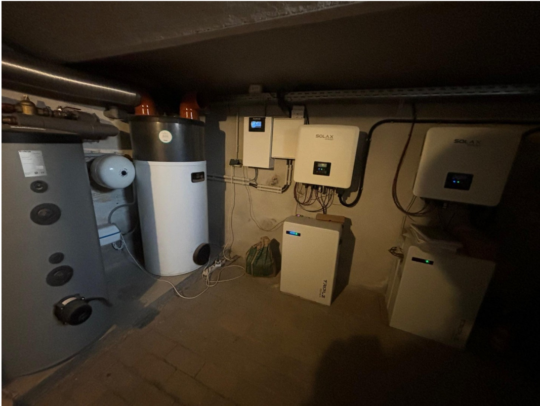
extra Warmwasserwärmepumpe
