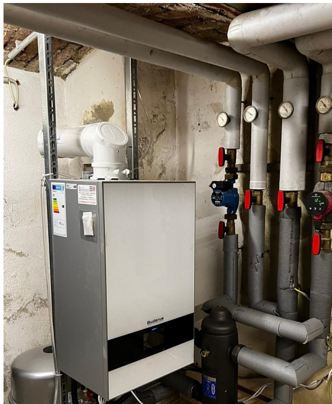
Brennwertheizung aus 2023
