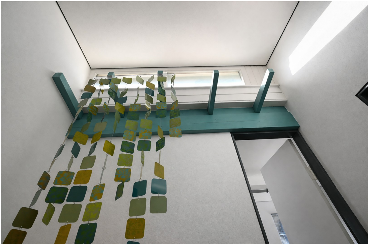
Blick in den Treppenaufgang
