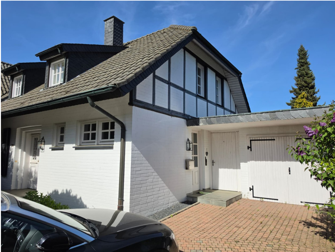
Haus vorne mit Seiteneingang
